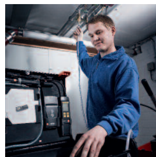
Проверка трубопроводов питьевого водоснабжения и трубопроводов сточных вод с зондом высокого давления до 25 бар
