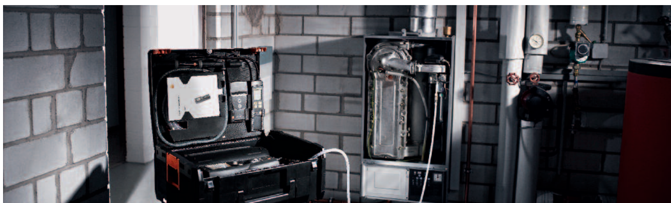
Автоматические тесты на эксплуатационную пригодность с помощью газоподводящего устройства при подключении к газовому котлу
